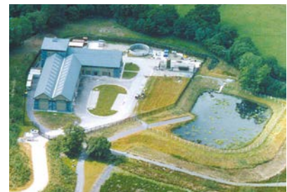
Beispiel für eine schwer erreichbare Pumpstation.
