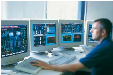
Dezentrale Management-Lösungen einschließlich SCADA, Vernetzung, Telemetrie und Industriemodems.
